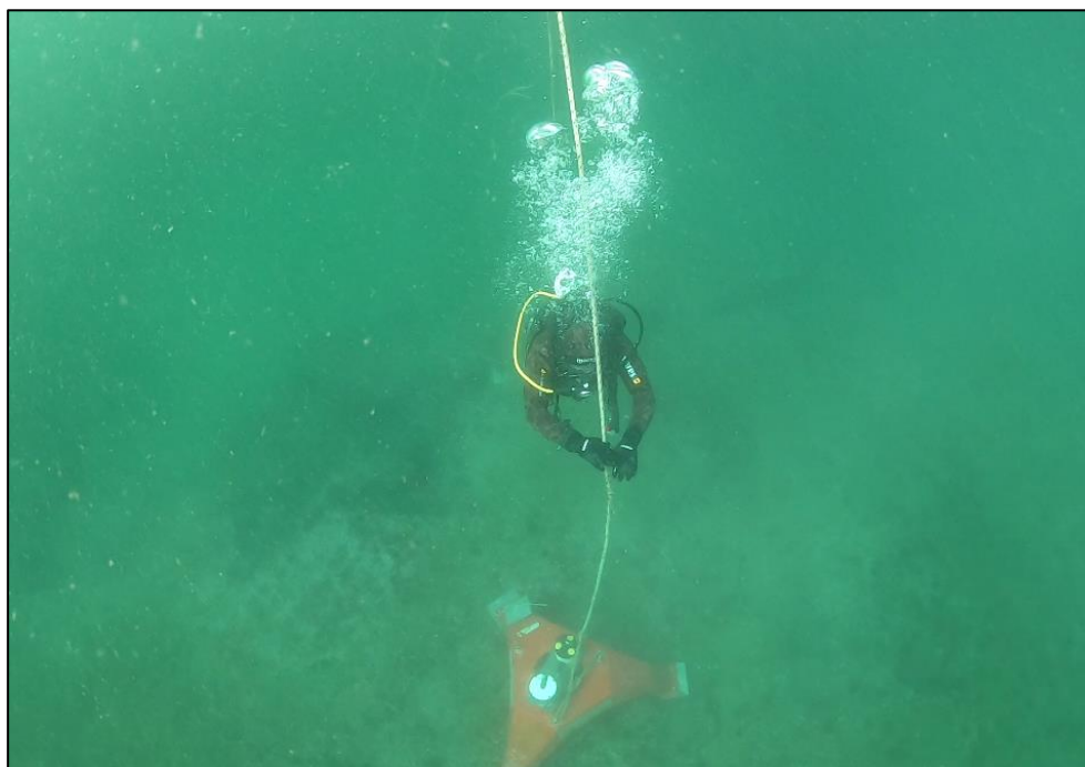
Figure 15: Mise en place de courantomètre au niveau du site d'étude (LEM)
