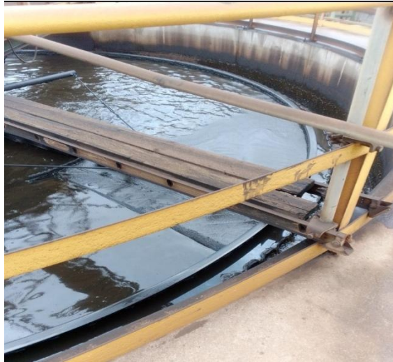
Figure3. 4 : Flottation à Air Dissous (DAF)
