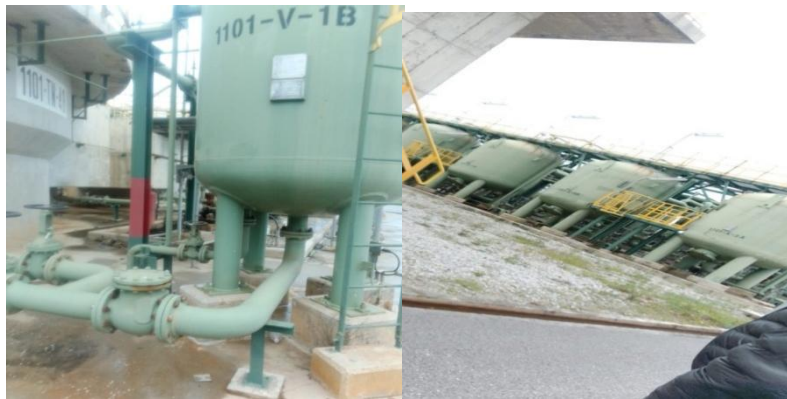
Figure3. 5 : Filtre à sable
