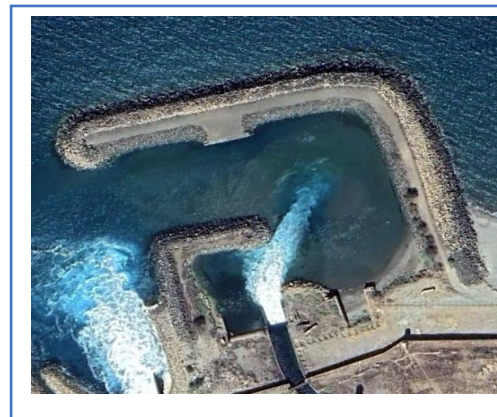
Centrale électrique de Cap Djinet
