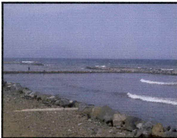
Photo n°3 : Epis de protection à Bou-Ismaïl.
