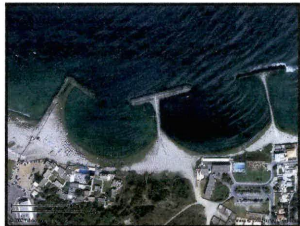
Fig n°55 : Epis de protection à Sidi Fredj.
