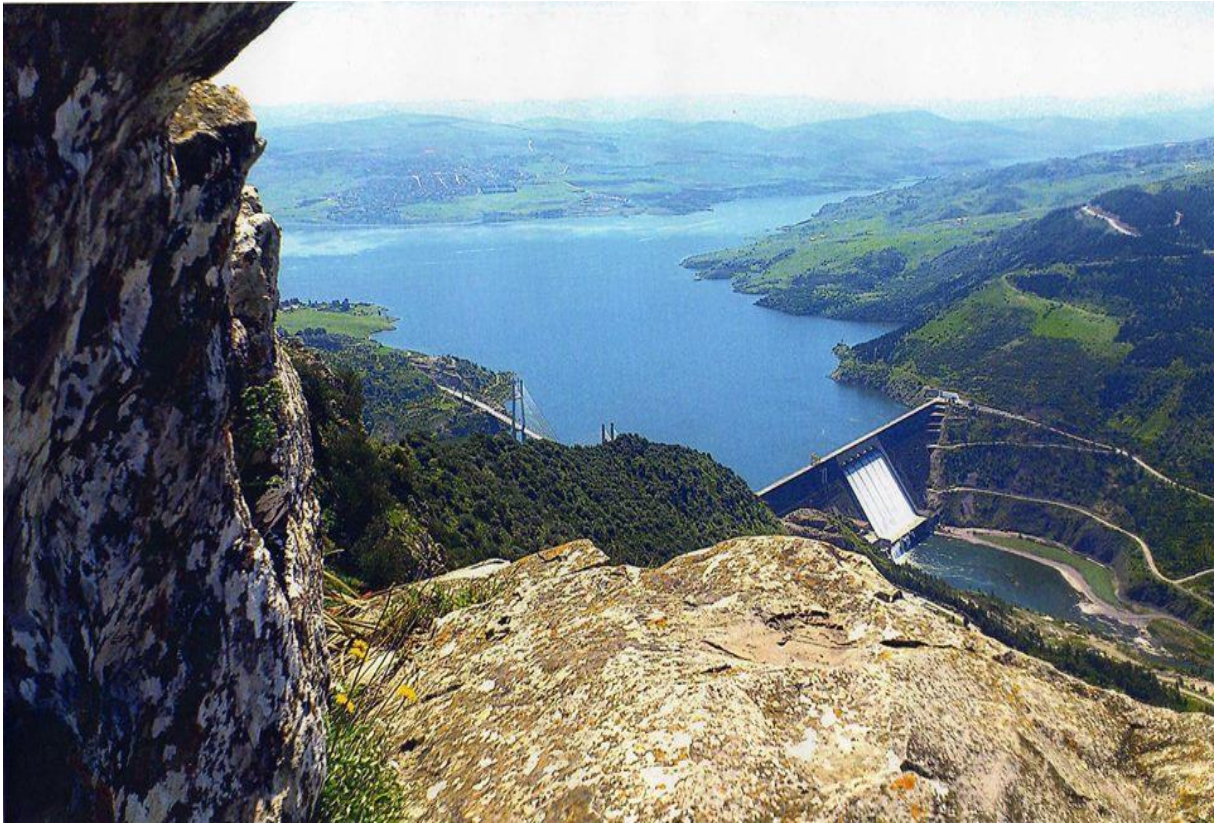
Fig. 06 : Vue générale du barrage Béni Haroun dans la wilaya de Mila (APRH, 2015)
