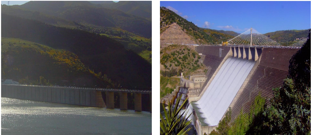
Fig. 07 : Vue de la digue du barrage de Béni Haroun côté de la retenue amont et côté d'aval (Prise de photos : Attar et Naceur cherif, 2015)
