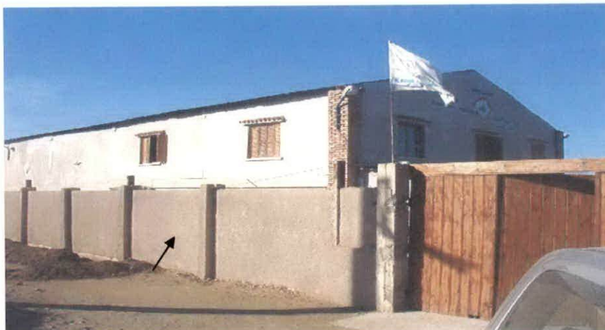
Photo N° (09) : Mur de clôture
