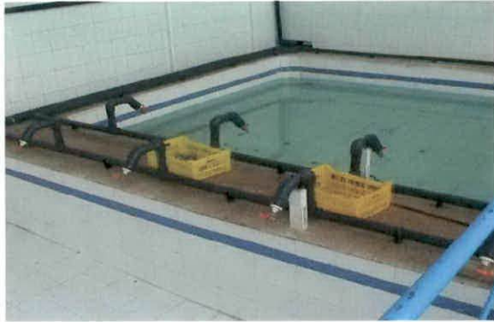
Photo N° (12) : Bassins de purification
