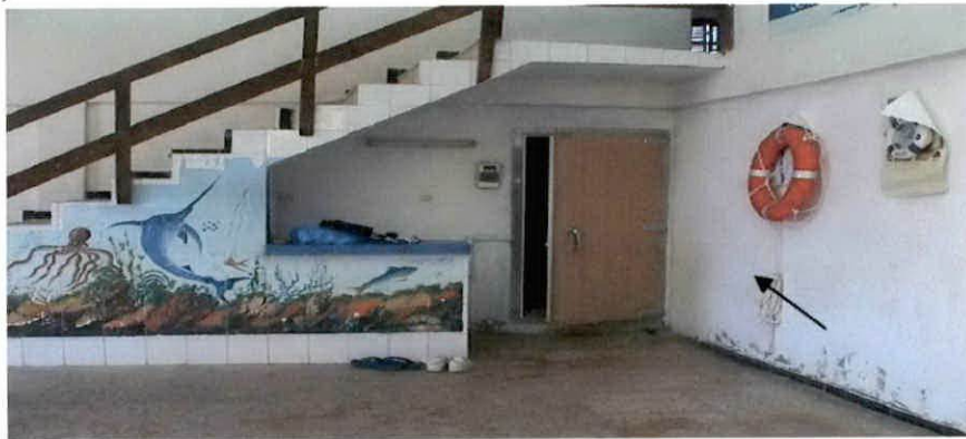
Photo N° (20) : Chambre froide
