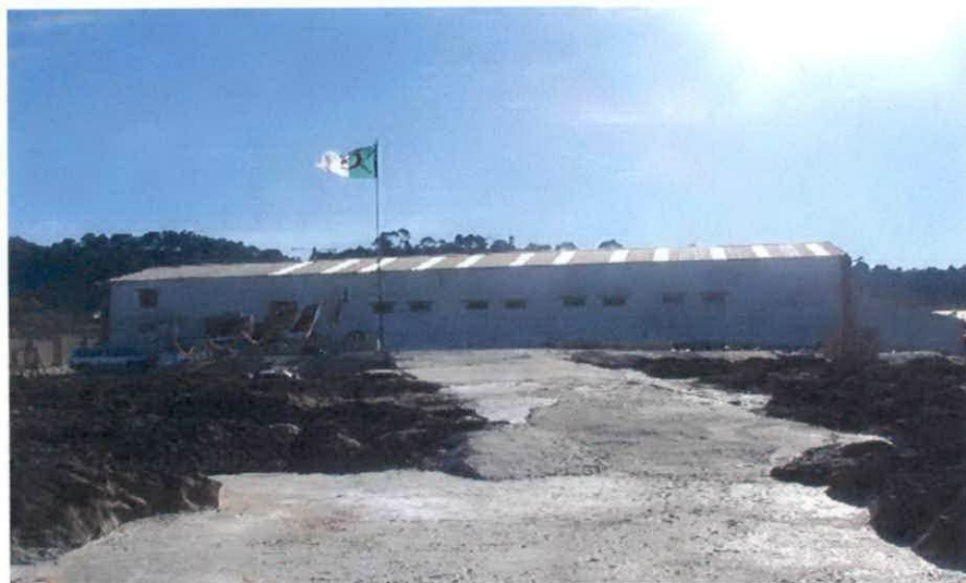
Photo N° (08) : Travaux d'aménagement du site (1991)
