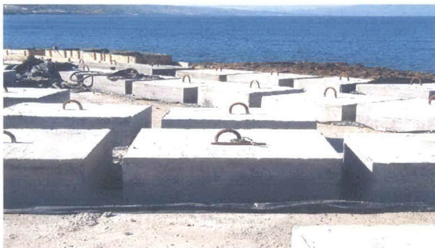
Photo N° (25) : Lests en béton armé
