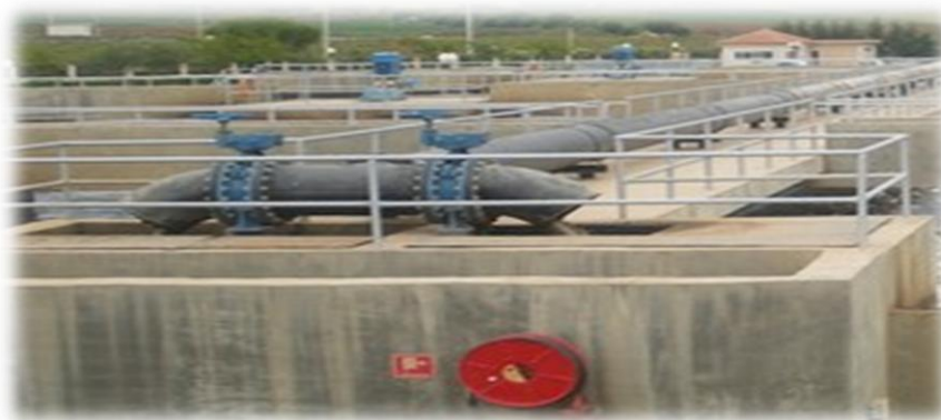
Figure III.11 : Poste de reprise des boues.
