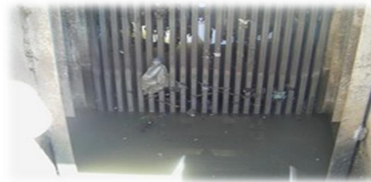
Figure III.5 : Dégrilleur fin.
