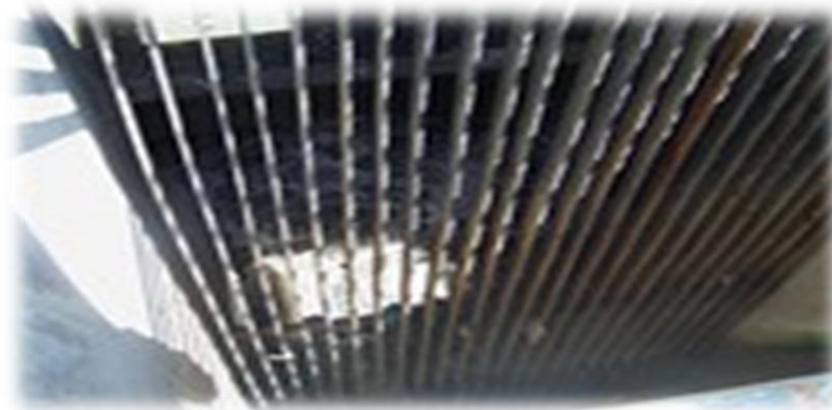
Figure III.4 : Dégrilleur grossier.
