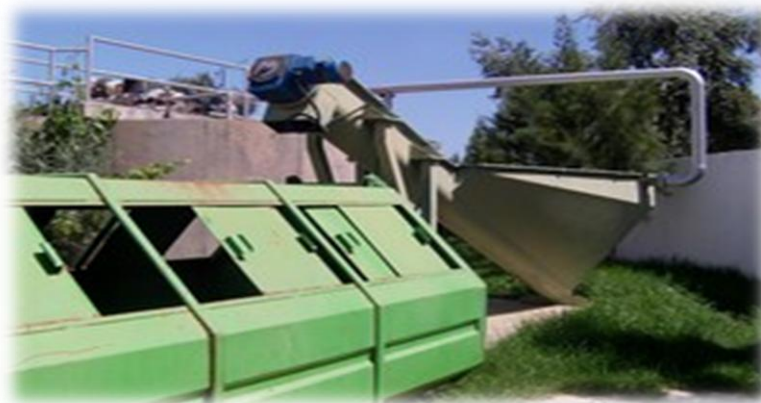
Figure III.7 : Classificateur de sable.
