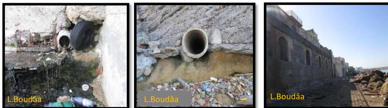
Figure II.3 : Déchets solides, rejets d'eau usée, éboulis artificiel dans la plage ouest de Sidi Fredj
