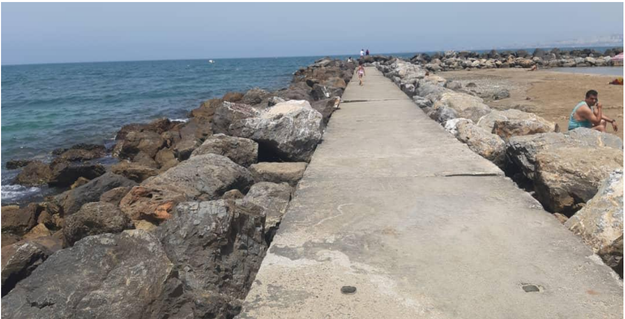
Figure 99 : Les ouvrages de protection de Sidi Fredj Ouest (prise le 15/06/2021)
