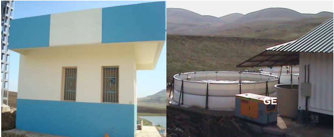
Figure 4 : Alimentation en électricité pour l'écloserie
