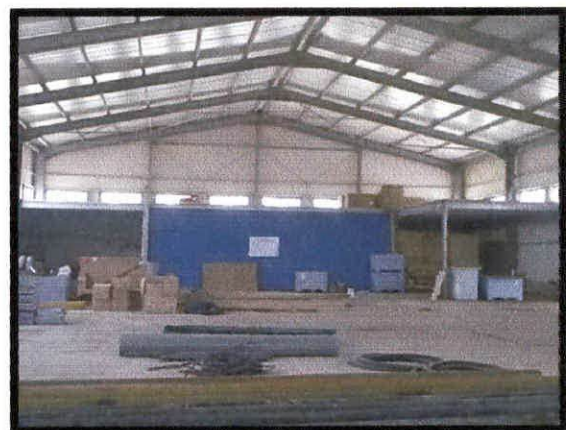
Figure 61 : Vue interne du hangar n°1
