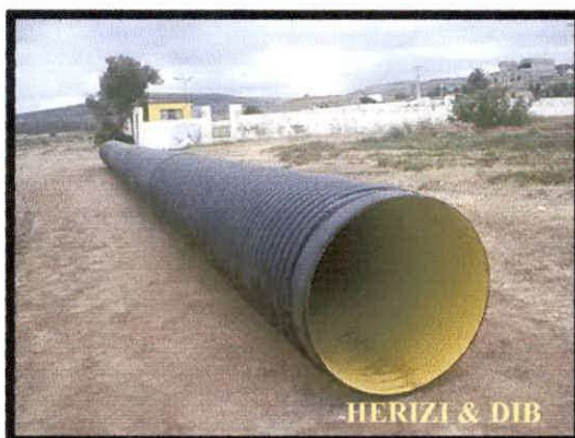
Figure 24: Tuyau d'alimentation en eau de mer
