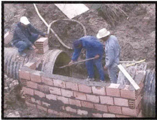
Figure 56 : Travaux d'une station de surveillance des eaux de mer
