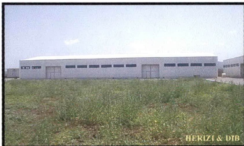
Figure 20: Vue extérieure du hangar n°1 : bâtiment d'exploitation (AQUATAFNA, 2007)
