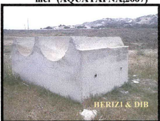
Figure 27: Structure en beton "cavalier" pour l'installation des tuyaux en mer
