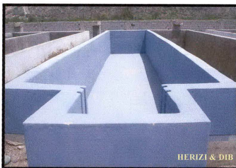
Figure 47: Bassin de prégrossissement
