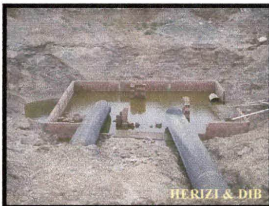
Figure 25 : Station d'arrivée de l'eau de mer (AQUATAFNA,2007)
