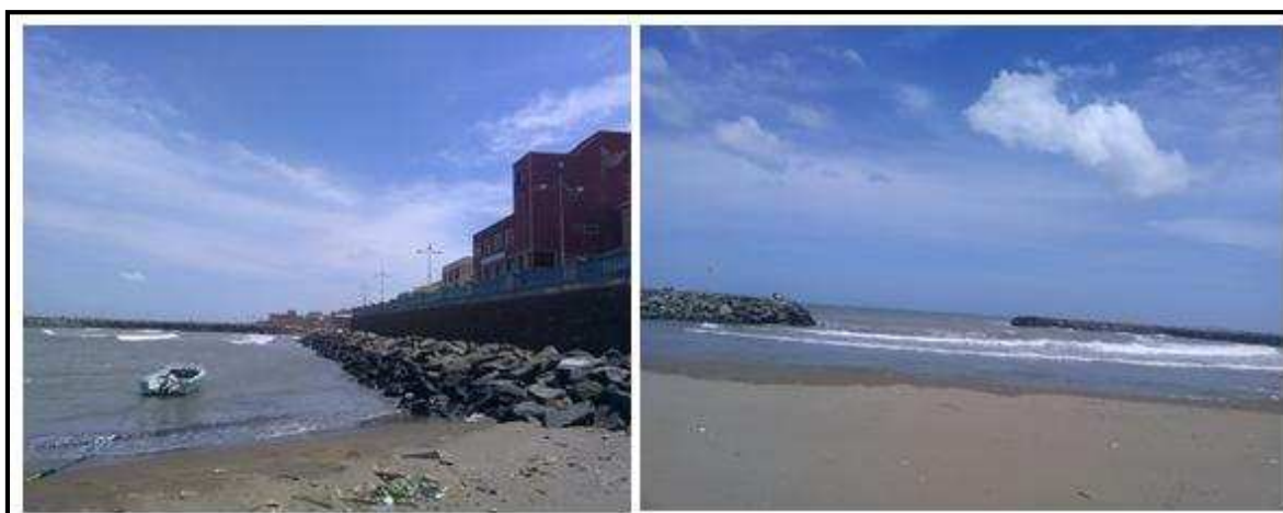
Photo V.3 : Ouvrages mixtes de la protection de la frange côtière de Bordj El Kiffan
