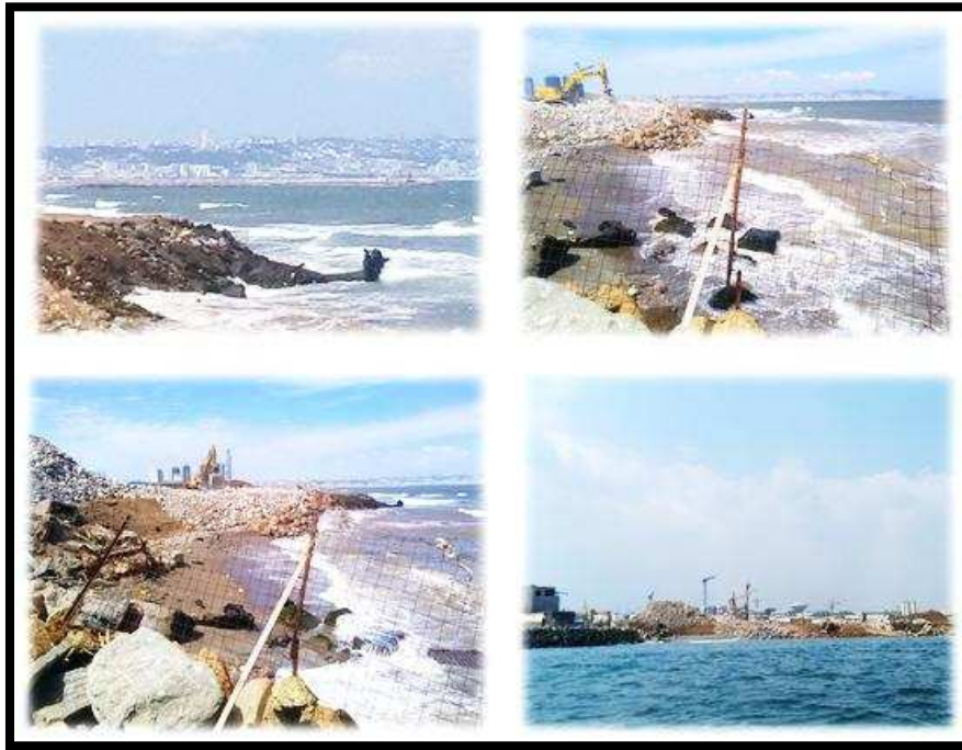
Photo II.3 : Chantier d'implantation d'un ouvrage de protection à proximité de la zone d'étude (zone militaire Lido, 2018)
