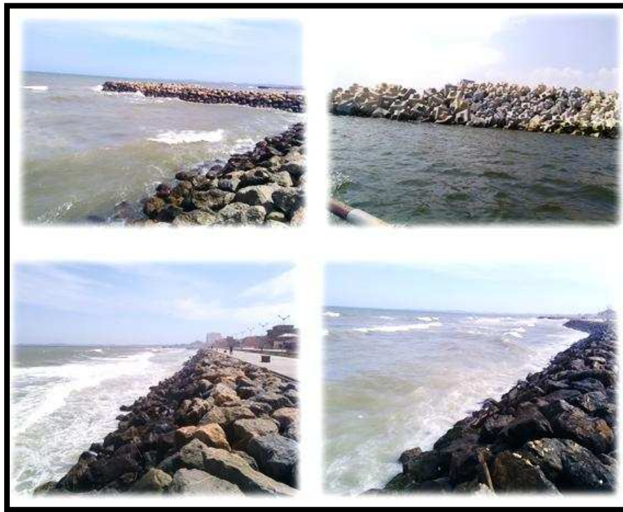
Photo II.1 : Ouvrages installés au niveau de la zone d'étude (plage Lido, 2018)
