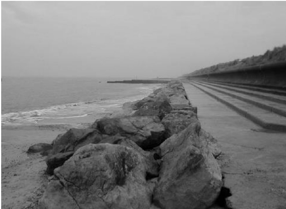
Figure 7: Protection anti-affouillement d'un mur chasse-mer, Happisburgh, Royaume-Uni (blocs en enrochement naturel posés au pied d'un mur chasse-mer en béton).
