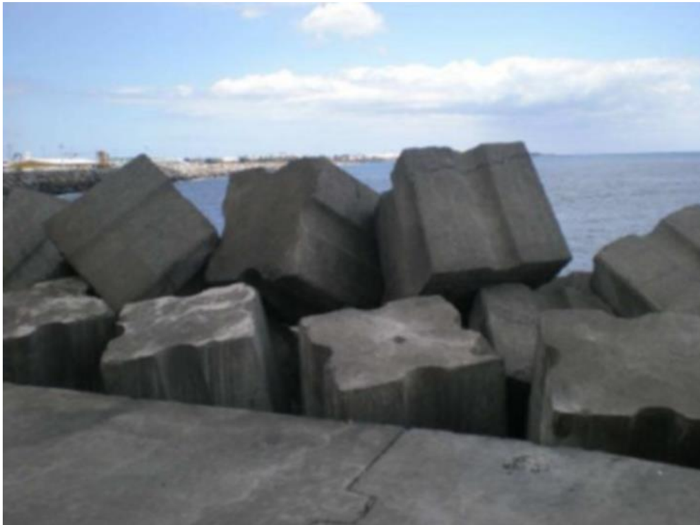
Figure 43: protection l'aide de bloc artificiel
