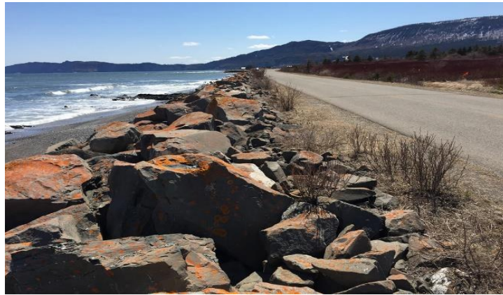
Figure 3: Protection d'une route côtière avec des enrochements naturels.
