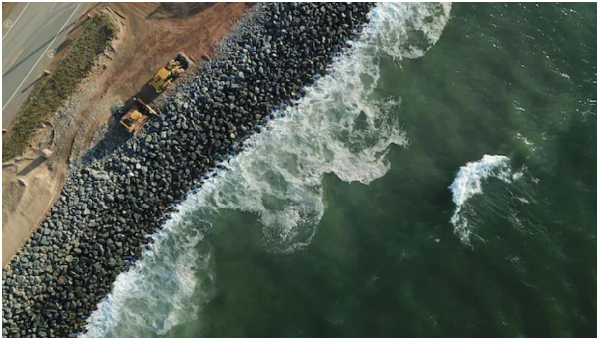
Figure 41: protection côtière à l'aide des enrochements naturels sur la route 199 aux Îles-de-la-Madeleine (radio-canada.ca)
