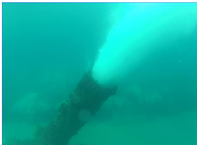
Figure 3: Émissaire du rejet de saumure avec diffuseur de la station de dessalement de Fouka (Belhanafi et al., 2016)
