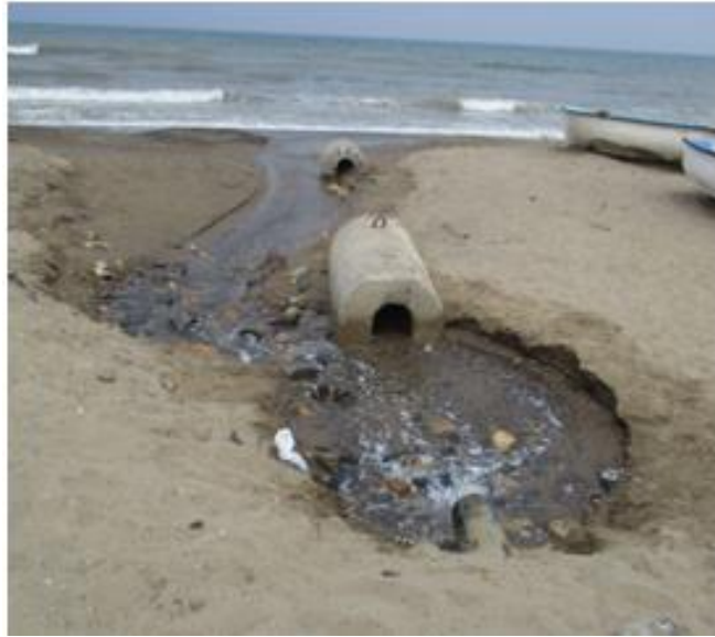
Figure 2: Rejet à la côte de la saumure produite par la station de dessalement de Palm-Beach (ADEM, 2017)
