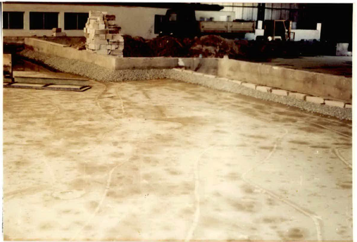
PHOTO 6 : Fond du modèle après construction, on remarque bien les isobathes.
