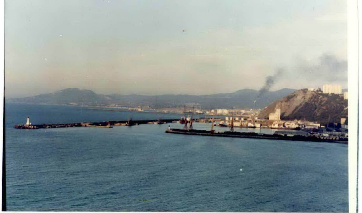
PHOTO 1 : Passe d'entrée de l'ancien port de skikda. Vue générale du port.
