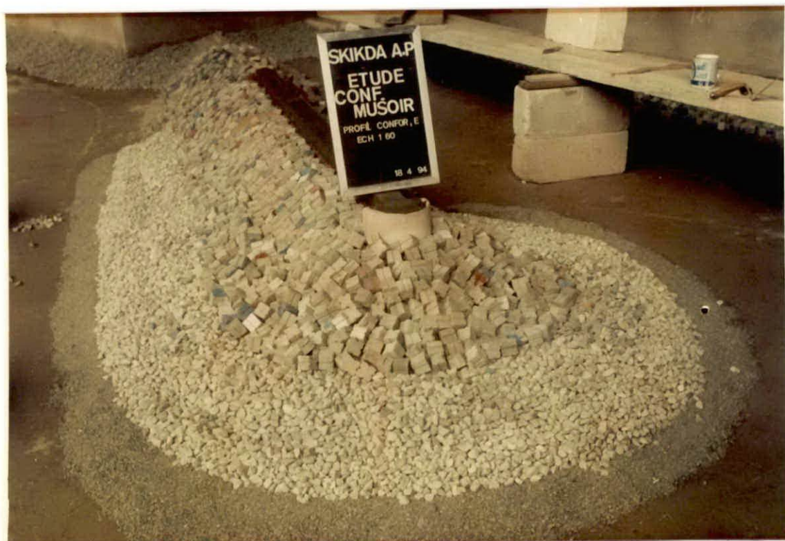
PHOTO 16 : Profil conforté, variante 1 en réalisation. (surelevation du mur de garde à la cote +9,50m) confortement du talus extérieur.
