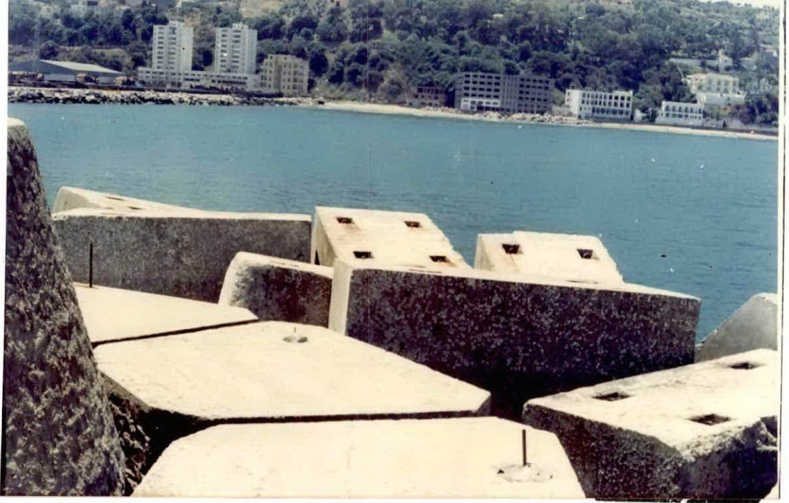
PHOTO 7 : Vue du Musoir rechargé provisoirement avec des blocs de quais de 50 t.
