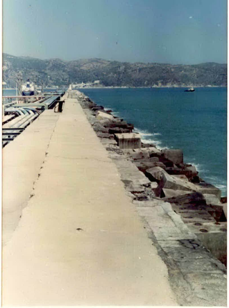
03 : Vue de la carapace rechargée en quelques endroits.
