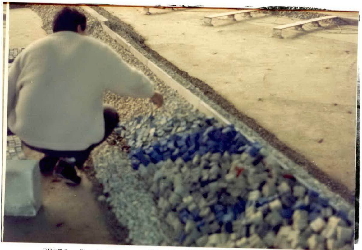
PHOTO 8 : Fosse manuelle de blocs de carapace.
