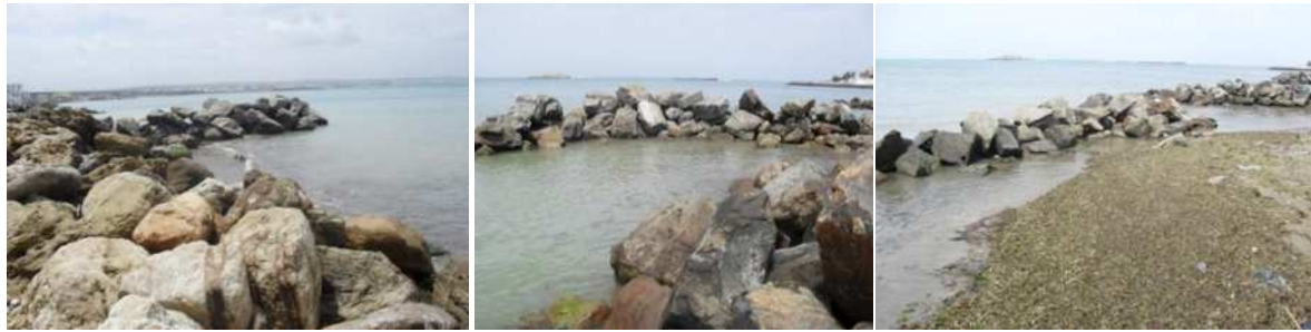
Photos VI.5. Les digues d'enrochement anarchiques dans la plage Ouest (07/03/2011).
