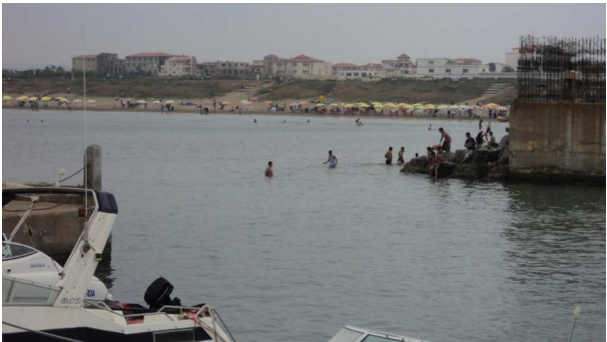
Figure n°I.2 : la passe d'entrée du port de Sidi Fredj 2011 (Belabdi et Ounnas, 2011).
