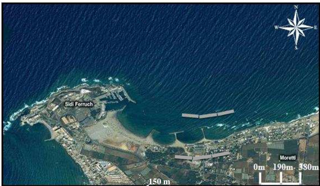
Figure n°III.9: Positionnement des géotubes dans la zone de Sidi Fredj (Bing map, 2011).
