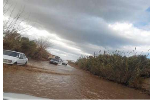
Figure V. 2 : Inondation à l'entrée de bou-smail
