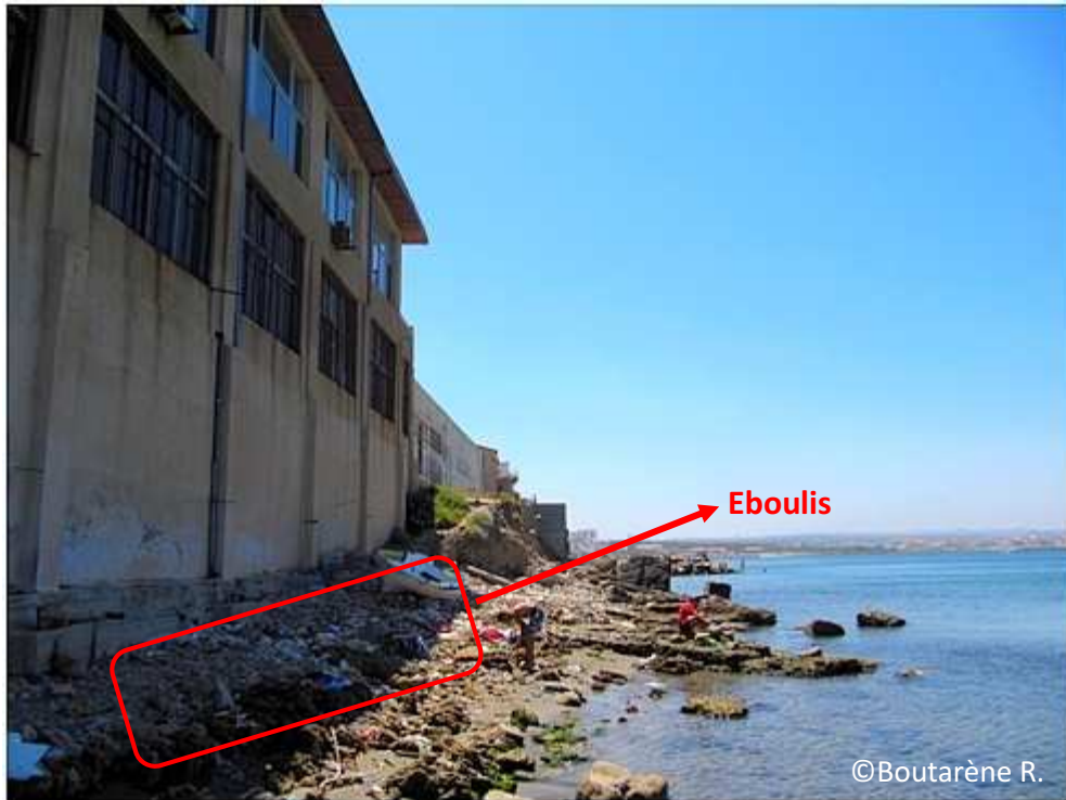
Fig. 37 : Eboulis due à l'érosion de la côte (plage ouest de Sidi Fredj.)
