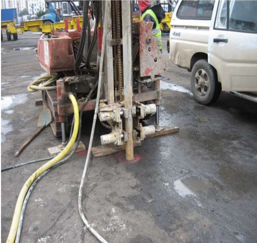
Figure II. 3. Exécution d'un sondage à l'aide d'une sondeuse Rolatec
