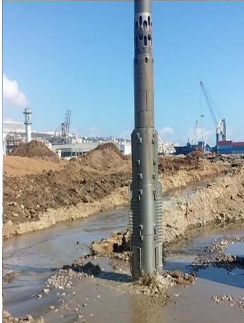
Figure III. 4. Vibreur en cours d'exécution (Lançage à l'eau et réalisation du forage)
