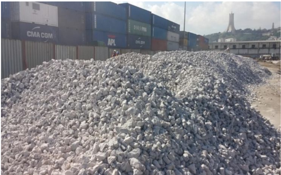
Figure III. 6. Approvisionnement du chantier en ballast (De la carrière d'El M'hir)
