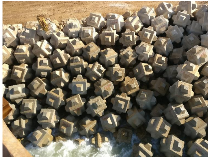
Figure 6 : des blocs de Cubipodes au niveau du musoir de la Marina El Bay D'Alger (BTP,2016)
