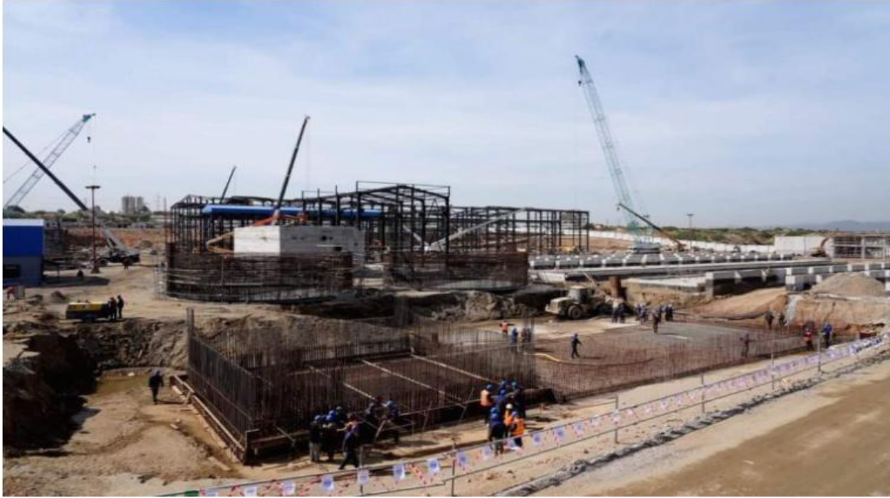
Figure 7 : la station de dessalement Cap Djinet 2 (en réalisation)
