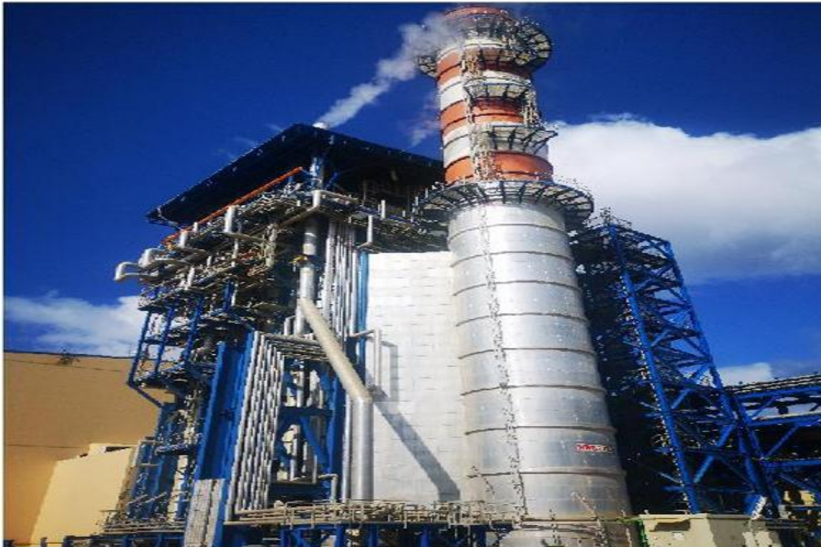
Figure 8 : La centrale électrique de Cap Djinet
