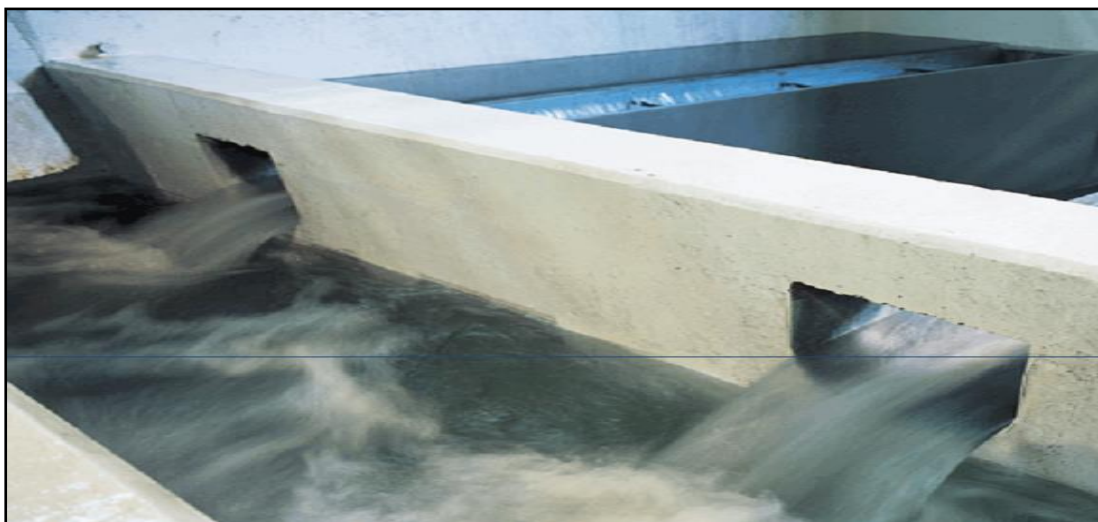
Figure V.09 : Filtre à sable bicouche
