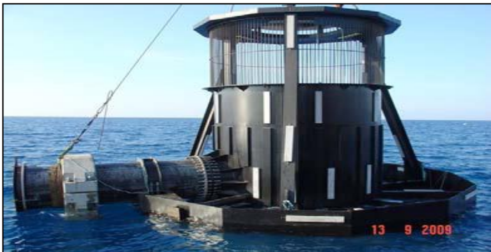
Figure V.06 : Tête de prise d'eau
