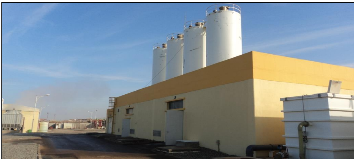
Figure V.13 : Silos de la chaux
