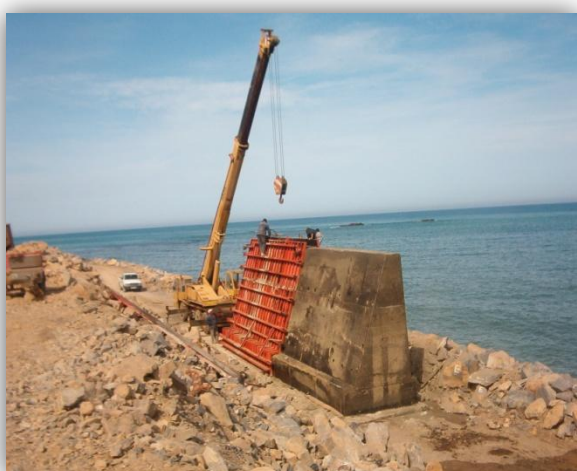
Photo n° 11: Fabrication du mur de soutènement
