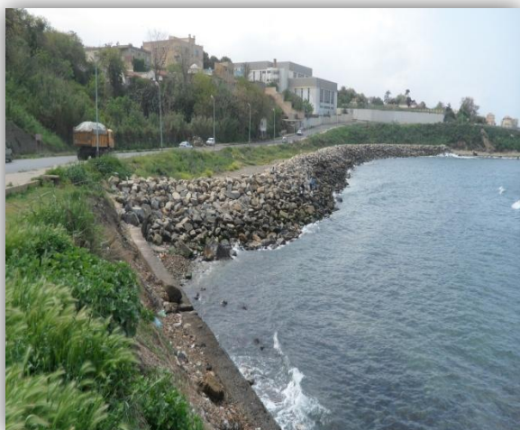
Photo n° 7: Ouvrage de protection -site Est-
