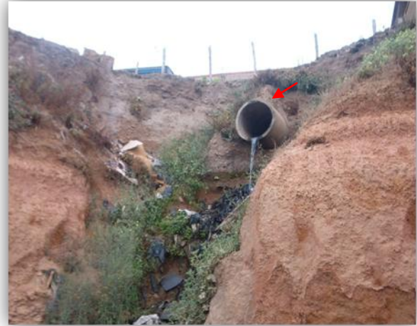
Photo n°2 : Embouchure d'eau usée dans la zone (absence d'un réseau d'assainissement).
