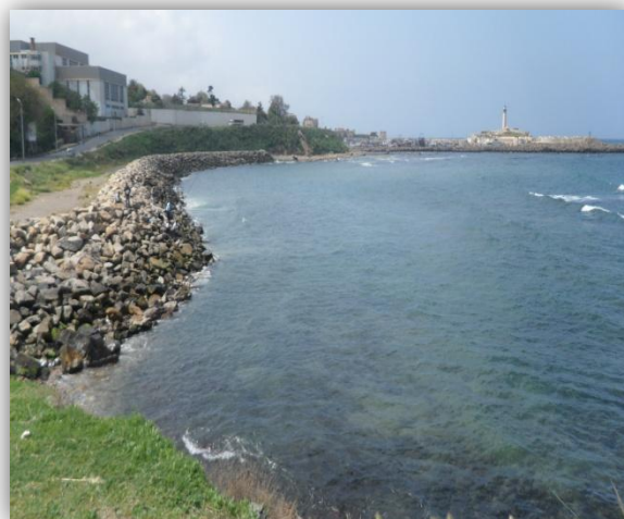
Photo n° 8: Ouvrage de protection -site Est-
