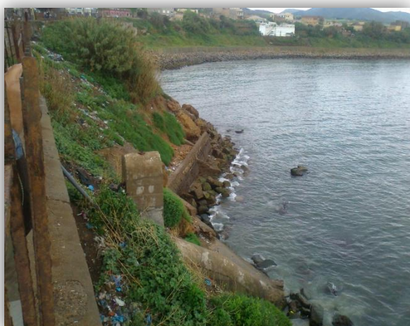
Photo n° 9: Ouvrage de protection -site Ouest-
