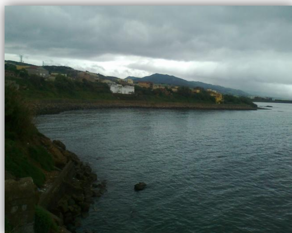
Photo n° 10: Ouvrage de protection -site Ouest-
