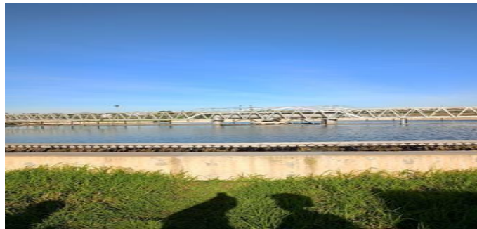
Figure 3-7 : Station d'Épuration des Eaux Usées de Baraki, Alger
