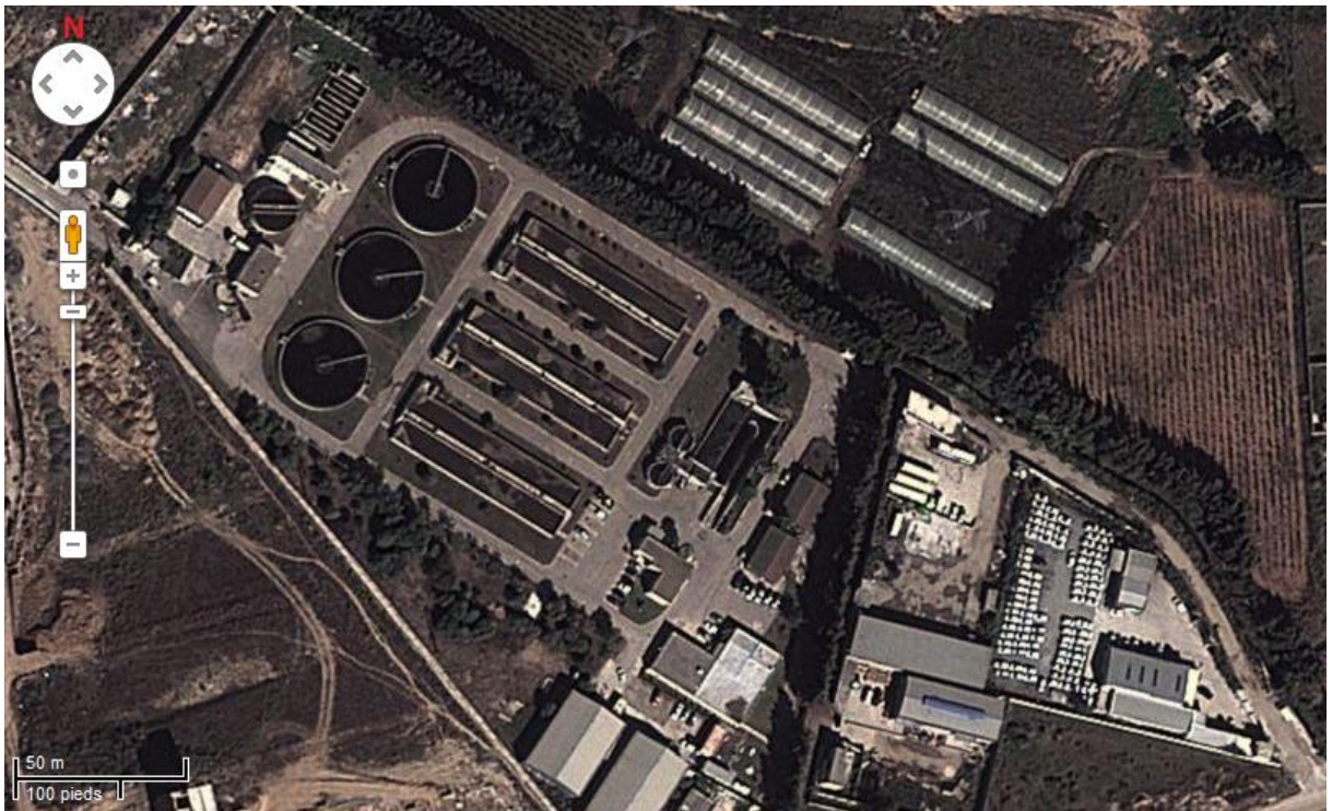
Figure 8: Photo satellitaire de la station d'épuration de BOUMERDES (Google Earth 2013).
