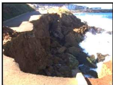
Photo 4 : Mur au niveau du débarcadère
