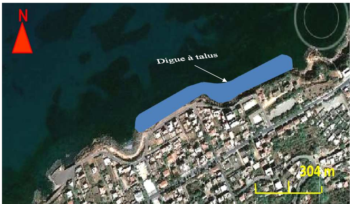
Figure 37 : Installation de l'ouvrage de protection sur la zone de Ain Tagourait
