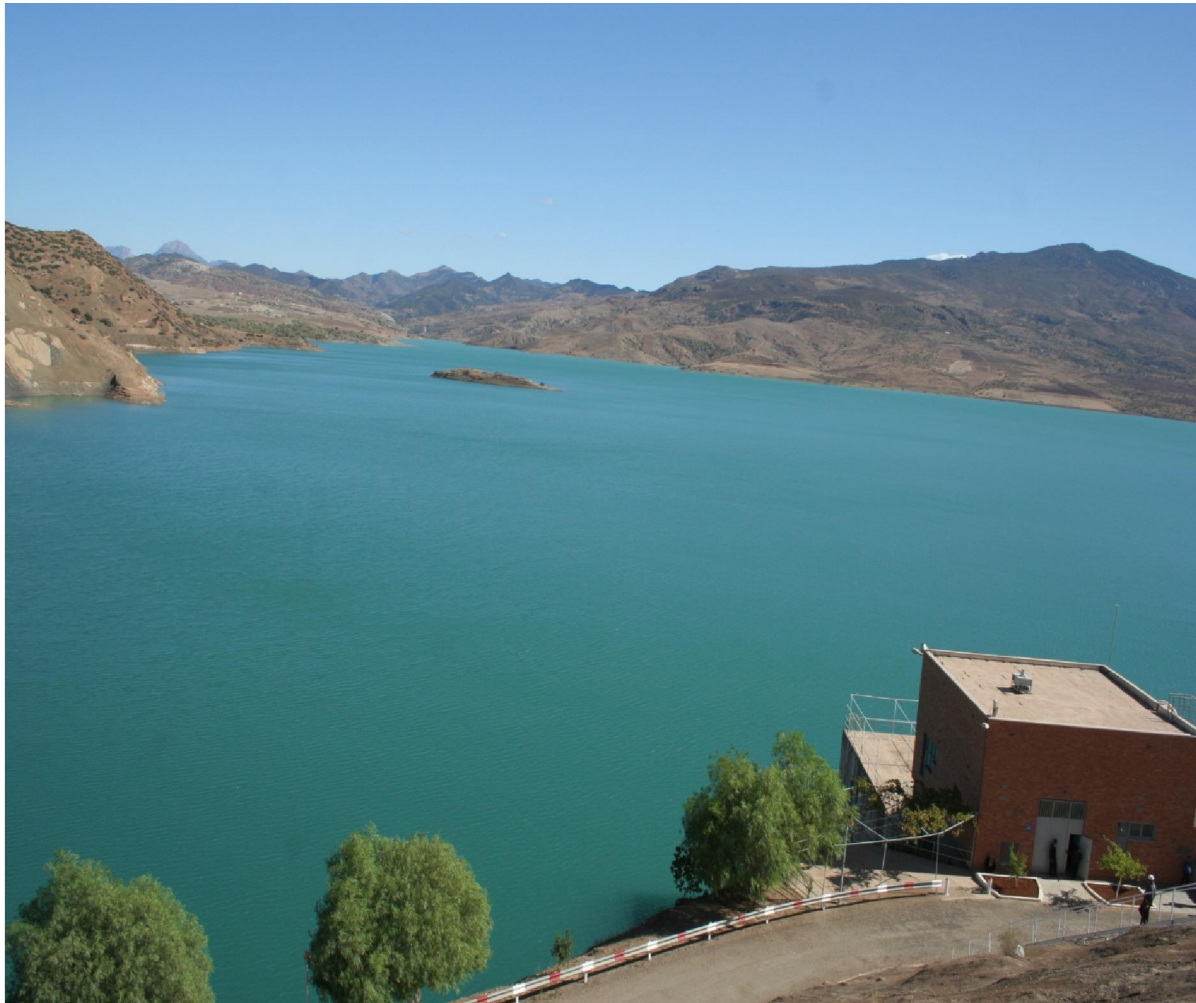
Figure N°3 : Photo de barrage Sidi-Yacoub (ANBT, 2010).
