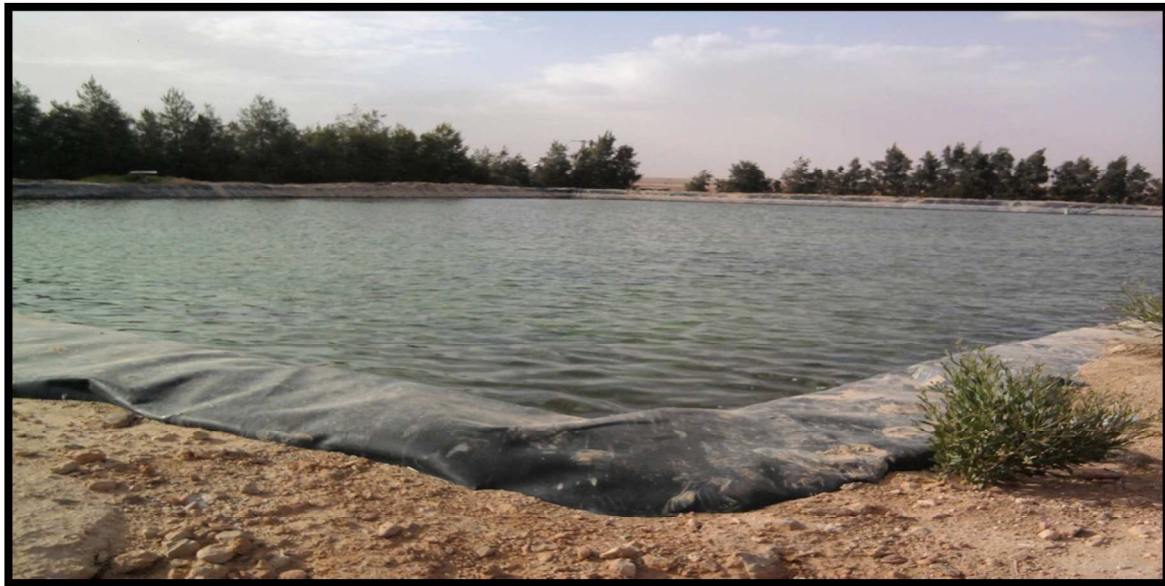
Figure N° 26 : Bassin réservoir. (Prise de photo personnelle, Mars 2013).
