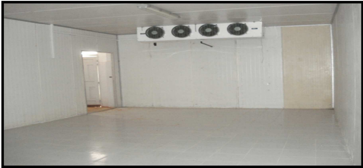
Figure N° 18: Chambre froide. (Prise de photo personnelle, Mars 2013).
