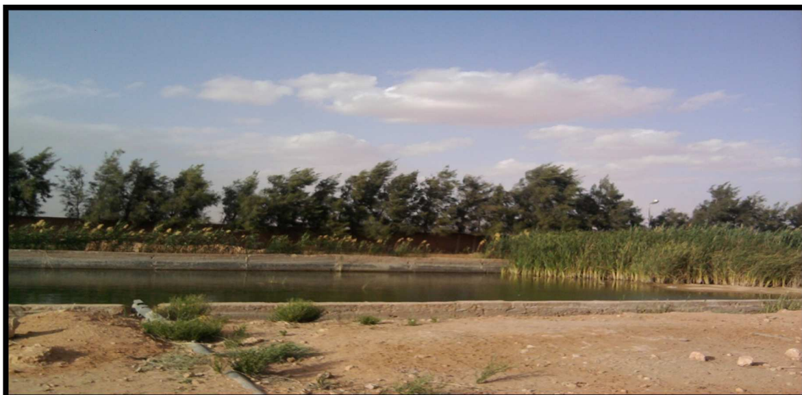
Figure N° 27 : Bassin de décantation. (Prise de photo personnelle, Mars 2013).
