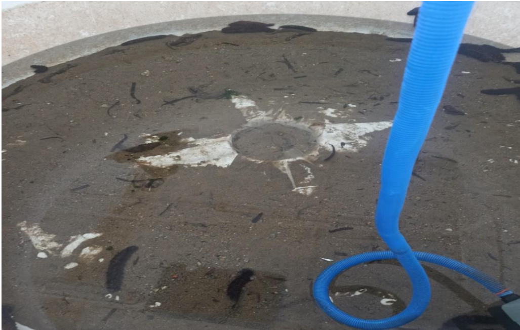
Figure 20 : photo montrant la couche de sable distribuée
