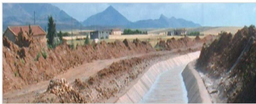
Canal artificiel en cours de réalisation
