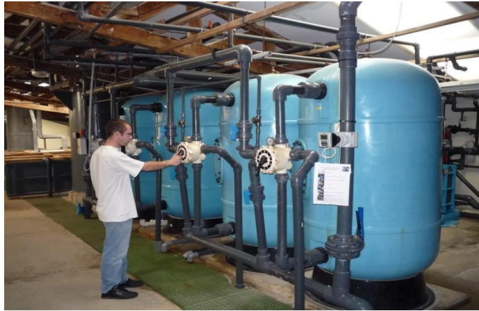
Figure I.7 : Cuves de filtration branchées en parallèle (Lemarié, 2009).
