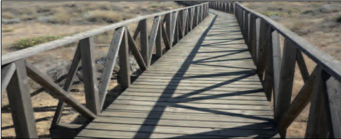
Figure 49 : passerelle d'accès à la plage (UICN, 2012).
