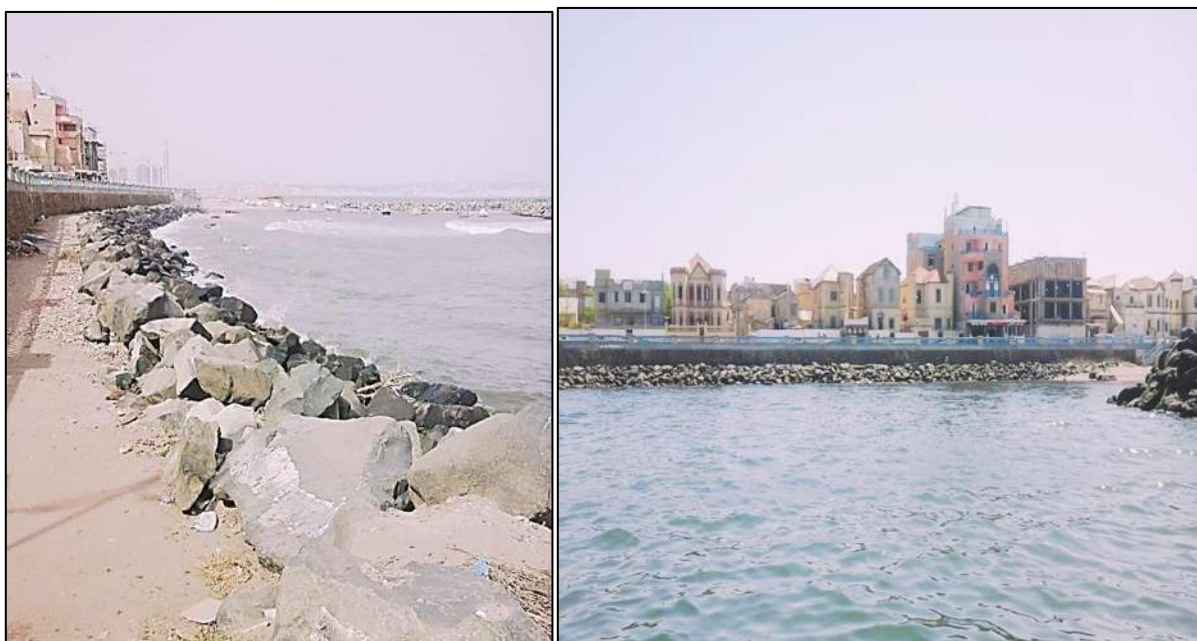
Photo VI.5: Cordons d'enrochements naturels au niveau de la zone de Bordj El Kiffan
