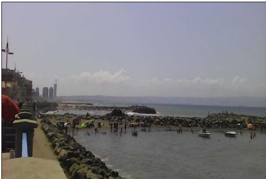
Photo VI.6: Les ouvrages mixtes de protection de la zone de Bordj El Kiffan
