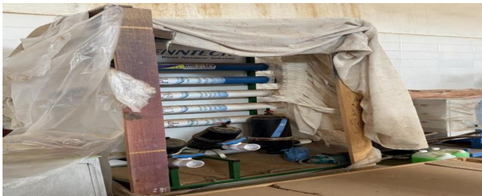
Figure 27: un système de filtration et stérilisation de l'eau par osmose inverse et ultraviolets (UV).
