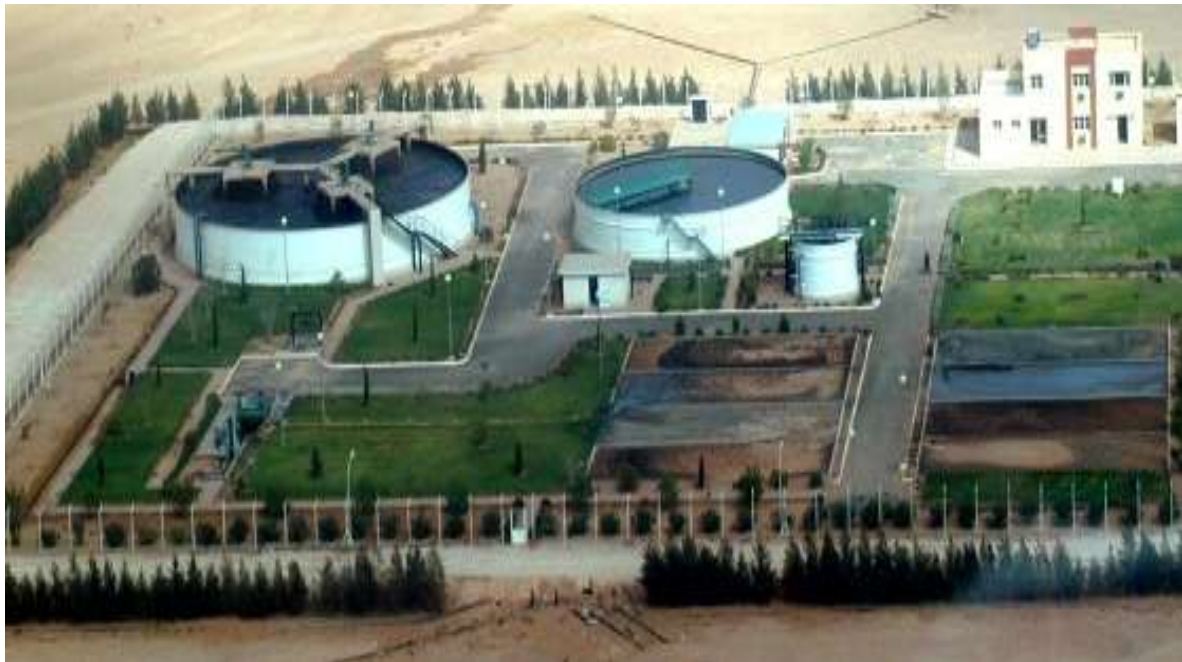
Figure II-4: Vue aérienne des installations de la station d'épuration de Hassi R'mel.
