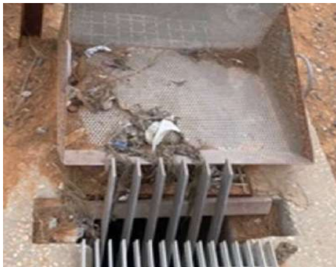
Figure II-6: dégrilleur
