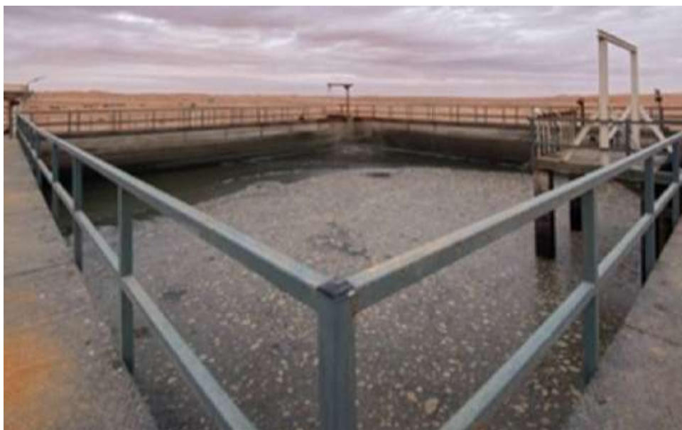
Figure II-5: bac de régulation
