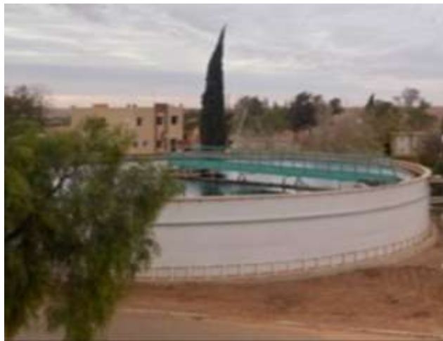
Figure II-8: bassin d'aération
