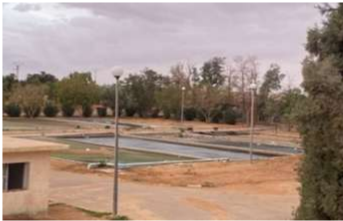
Figure II-9: représente un lit de séchage
