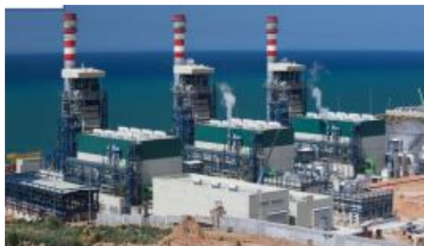
Figure 55. Centrale électrique du Cap Djinet.
