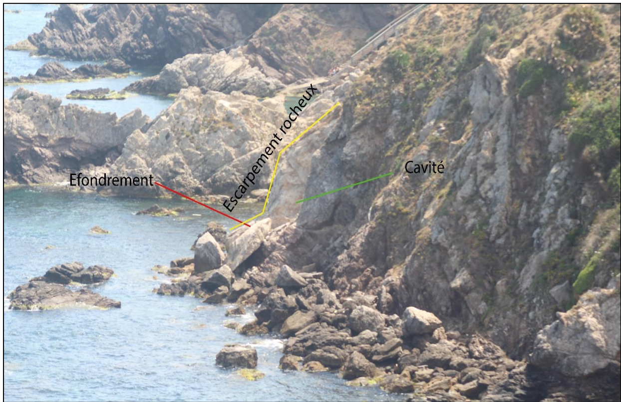
Figure 70: Effondrement des falaises sous l'action des vagues.
