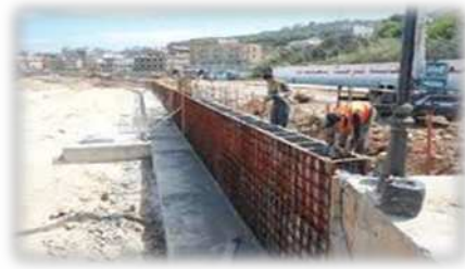
a- Construction de mur de protection
