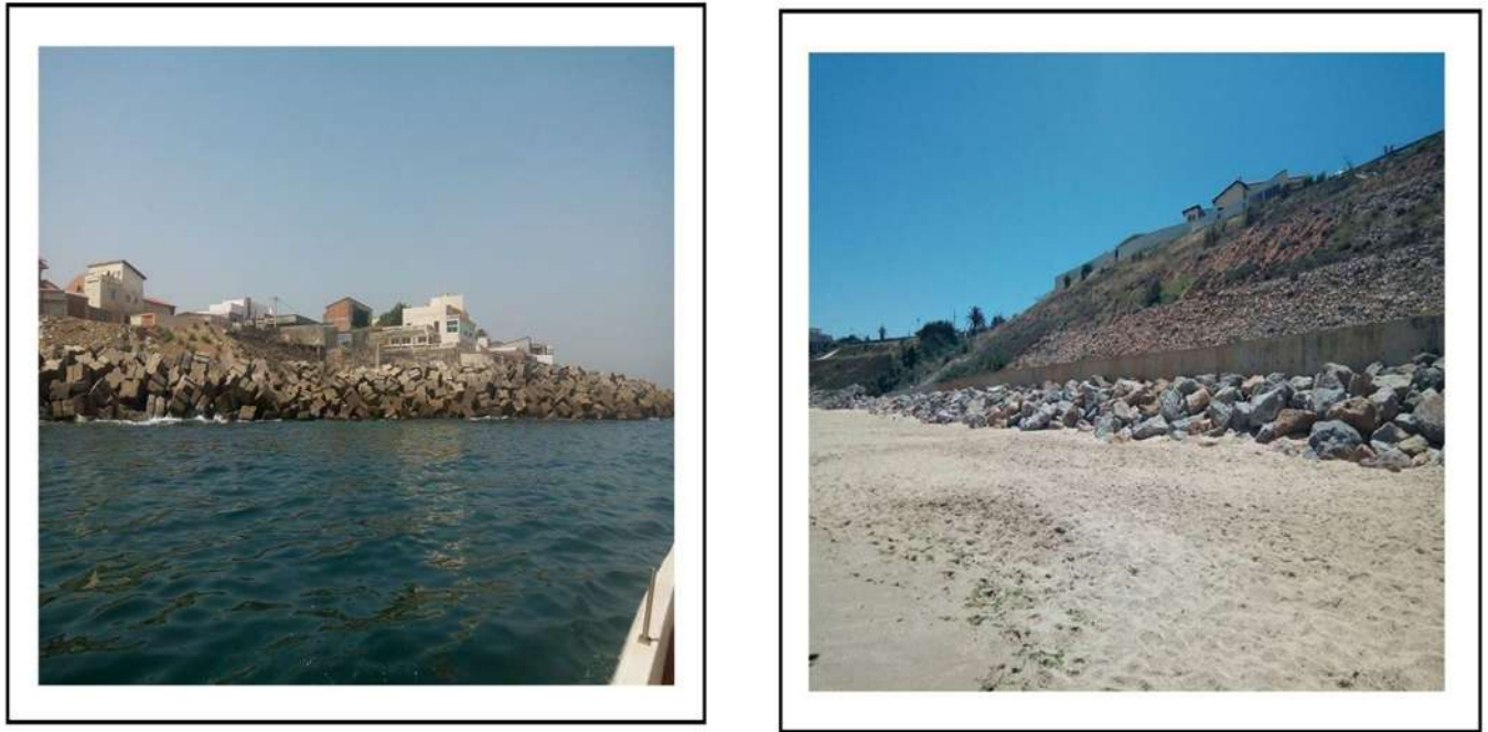
Figure III-10 Photo des enrochements de protection sur la plage Ain Beida (Année 2017)
