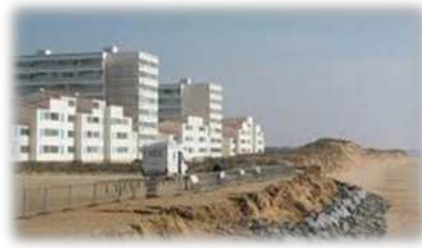
b- des enrochements de protection
