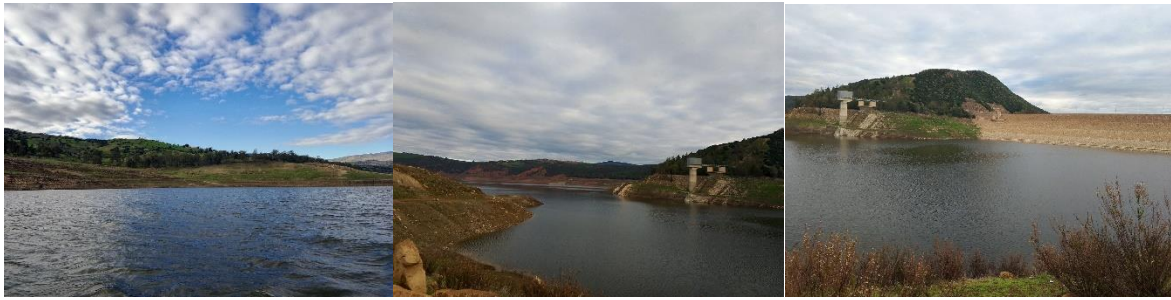
Figure 2. Vue générale du barrage de Bouhamdane prise lors de la campagne de terrain (présence d'étude)
