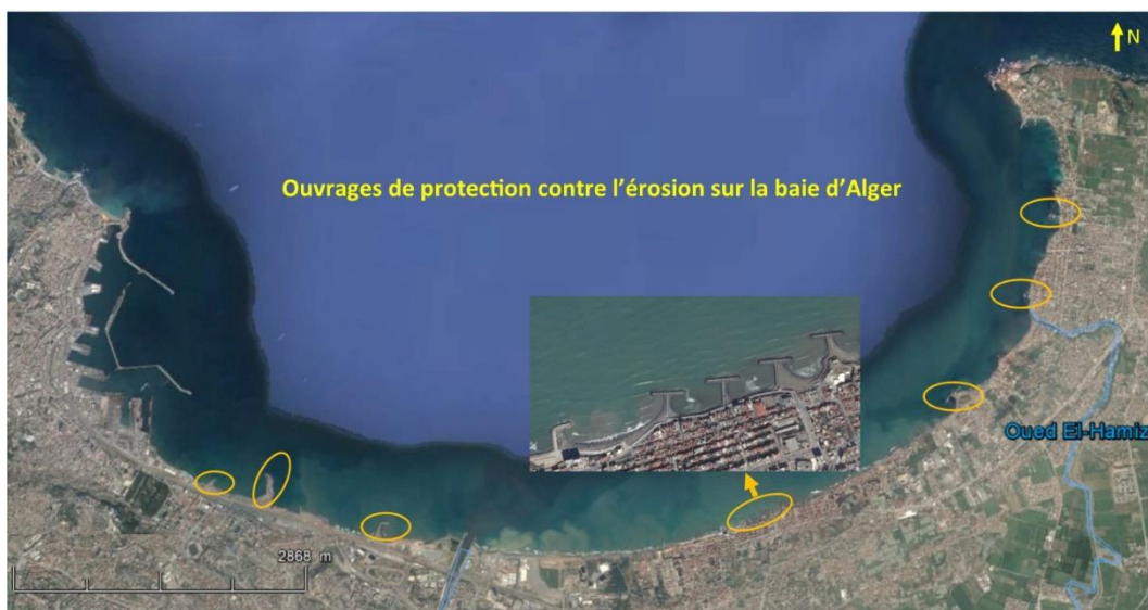
Figure 89: Structures de protection dans la baie d'Alger
