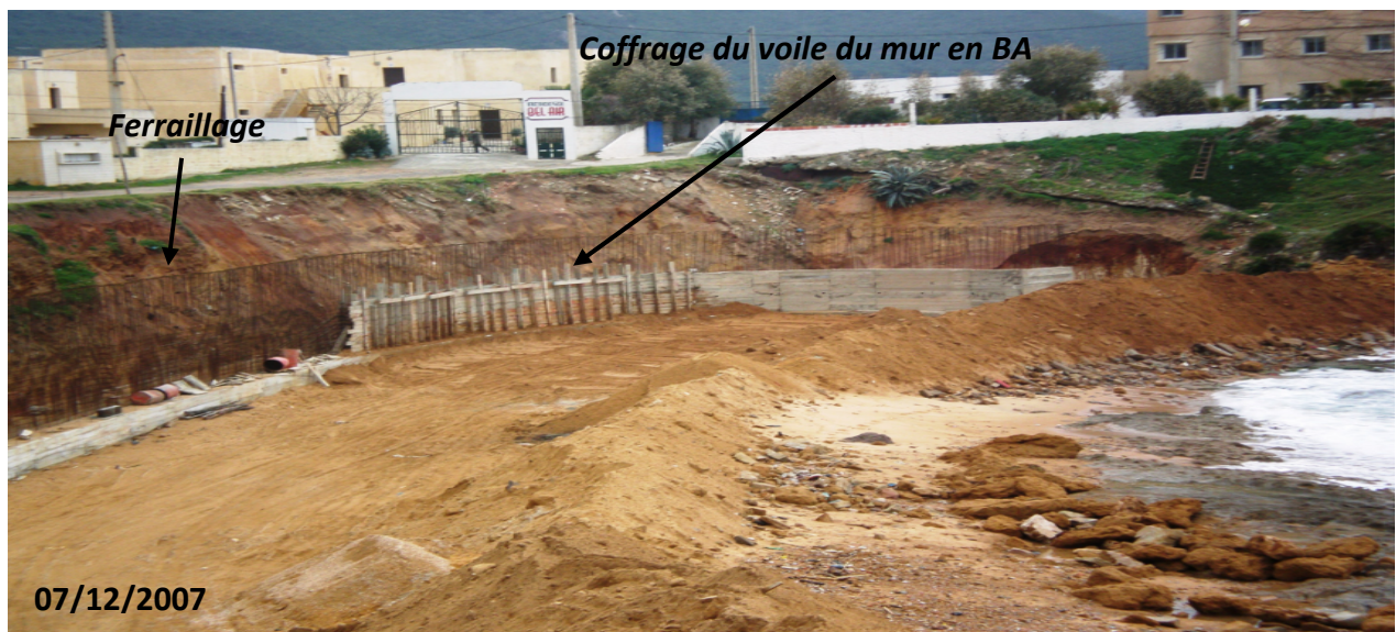
Figure N°II.3: photographie du Ferrailage et coffrage du voile du mur en B.A au niveau de la plage piscine au début des travaux (HMI).
