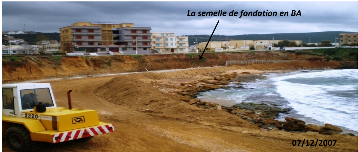
Figure N°II.2: photographie de la plage piscine au début des travaux (HMI).
