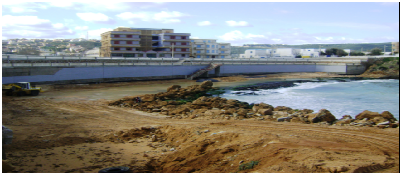
Figure N°II.7: géotube pendant la tempête du mois de Mars.
