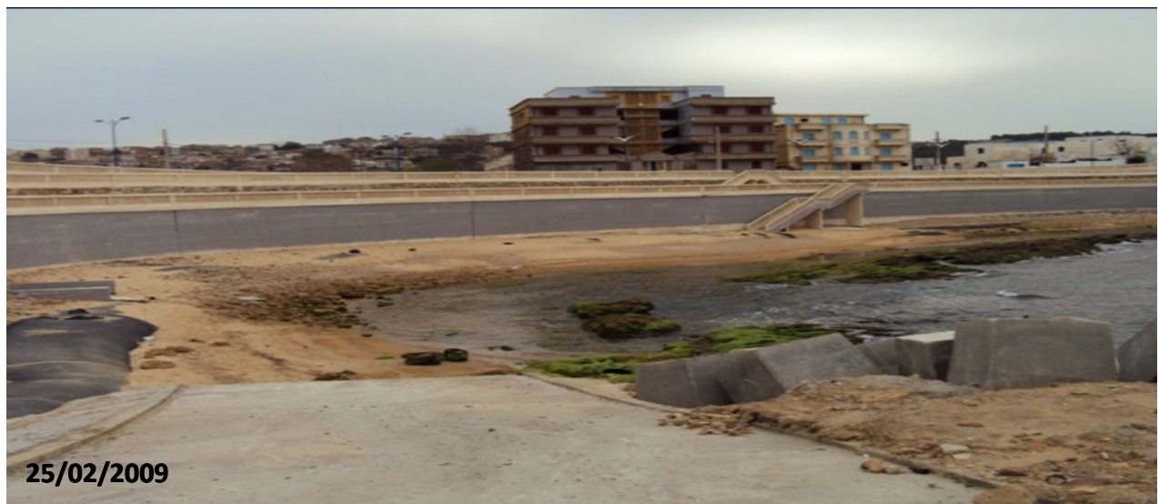
Figure n° II.6: photographie de la fin des travaux (HMI).
