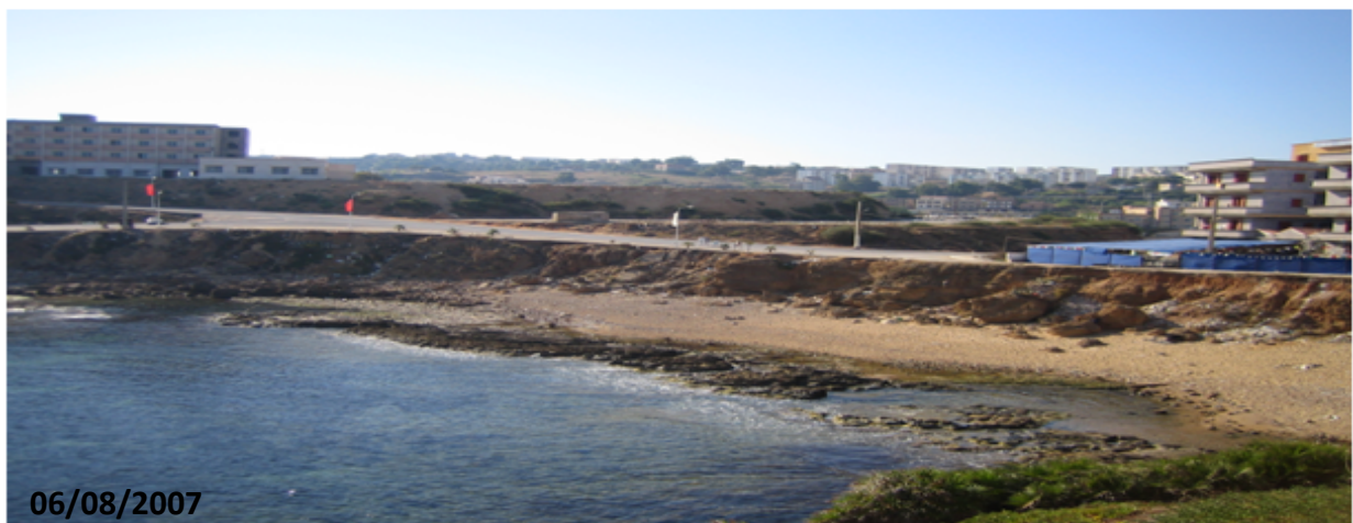
Figure N°II.1:photographie de la plage piscine avant le début des travaux (HMI).
