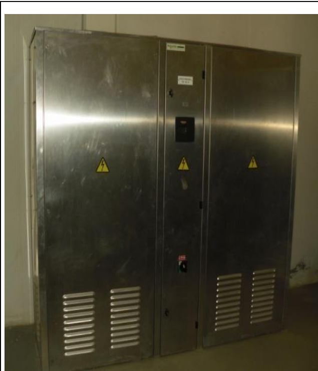
Batterie de compensation BT-N°01
