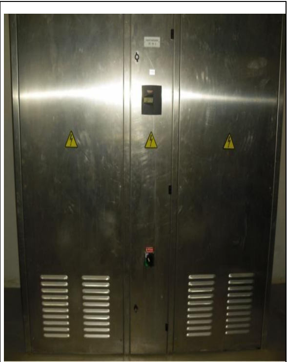
Batterie de compensation BT-N°02
