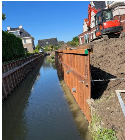
Figure 10: Wooden sheet pile sections. (Damwand Plaatsen - Stolze Grondverzet, n.d.)
