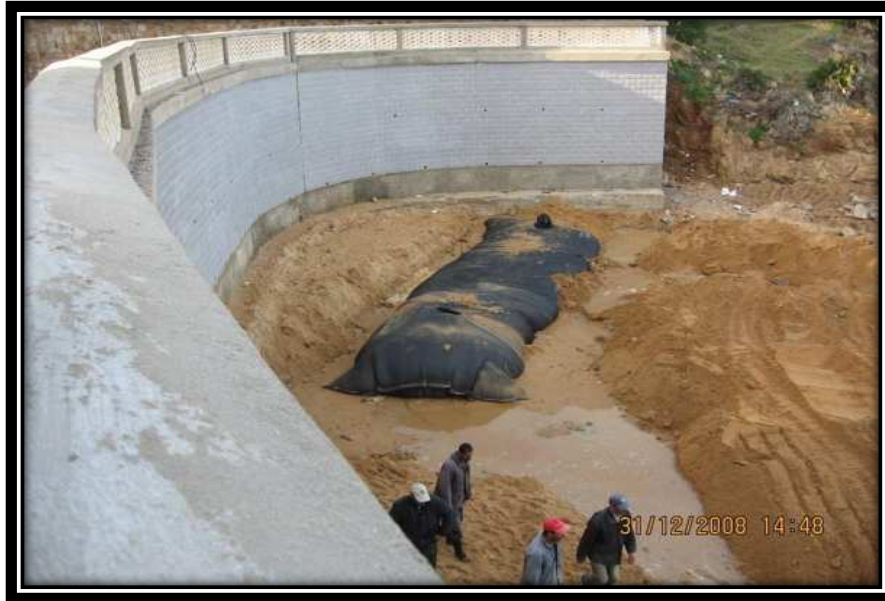
Figure IV.1 Installation d'un géotube, (expérience à El Kala 2008).
