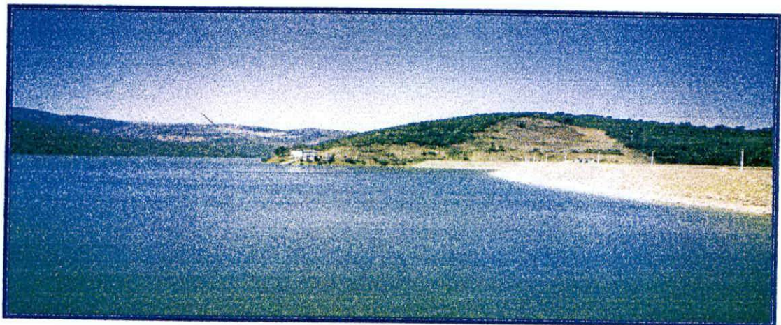
Station 2 : la digue du barrage
