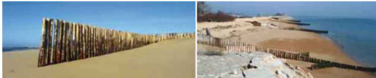
Figure 21 : Pieux hydrauliques transversaux, Cap Ferret, Aquitaine (France)
