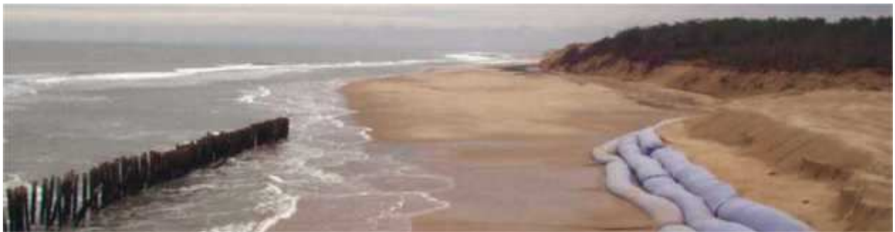
Figure 20 : Ouvrage en géotextile (France)
