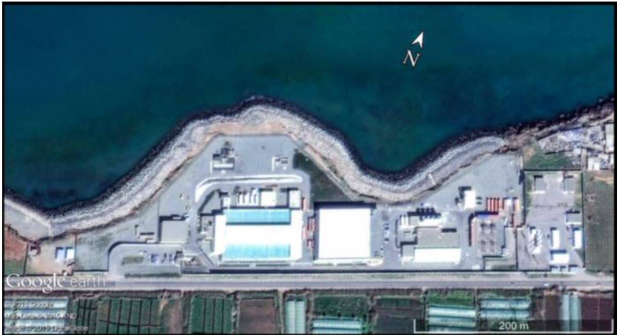
Figure 11 : Photo aérienne de la station de dessalement Fouka.
