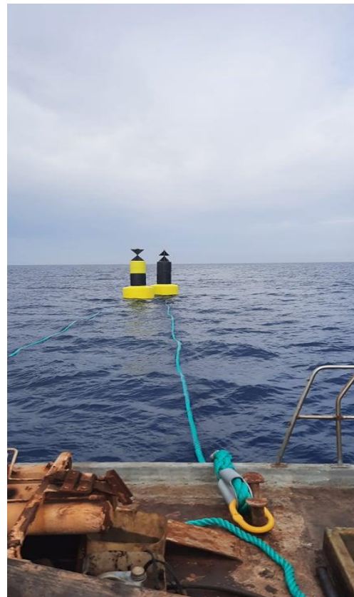
Figure 48: L'installation des balises en mer.
