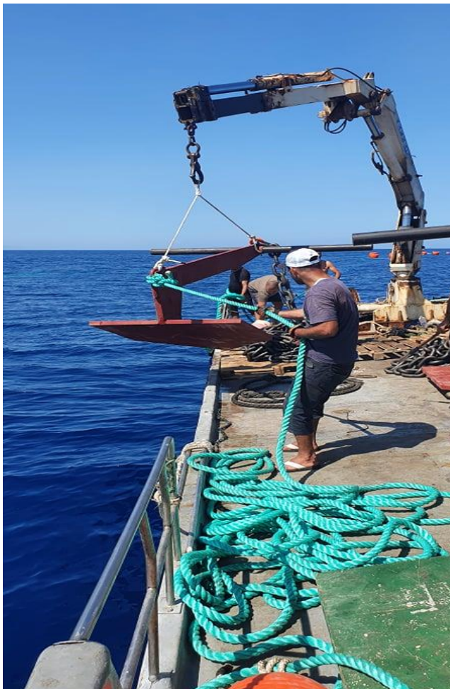
Figure 50: L'installation du système d'amarrage.
