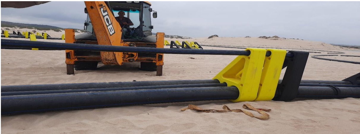
Figure 25: Les composantes de la cage flottante avant installation.
