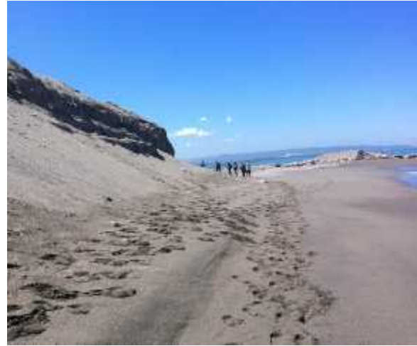
Photo n°02 : Accumulation massive du sable au niveau de l'épi Nord.
